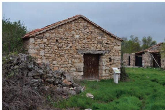
Antiguamente el abastecimiento de agua se hacía mediante dos **aljibes** que presentan la tipología típica de la zona: Aljibe de mampostería de la zona, granito, gneis, cuarzo. Utilizado para el depósito y transporte de agua.
